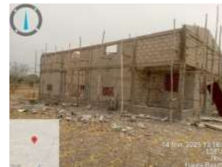
Magasin en construction sur site
