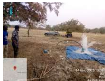
Forage en construction sur site
