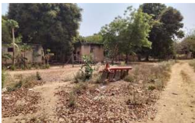
Photo 6 : Vue de quelques installations du site identifié pour servir de base-vie
